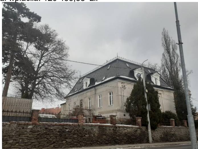
Remont pokrycia dachowego ul. Bolesława Chrobrego 19
